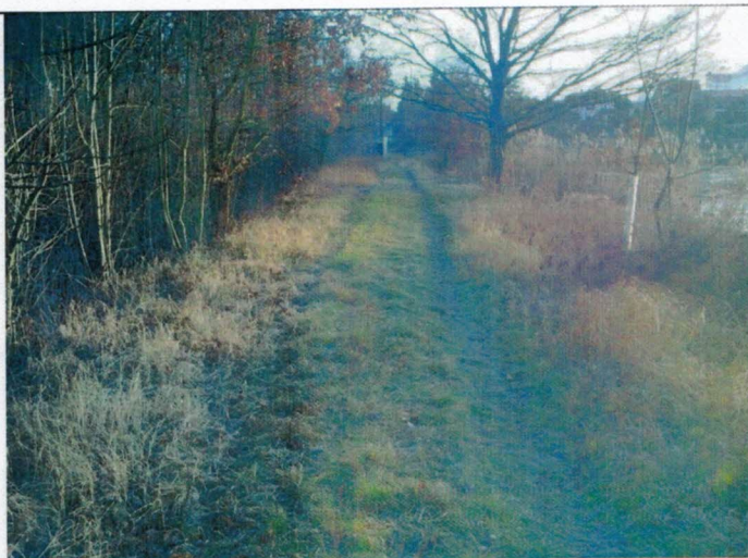
Foto G.2.3 Pohled na korunu severní hráze (čelní)
