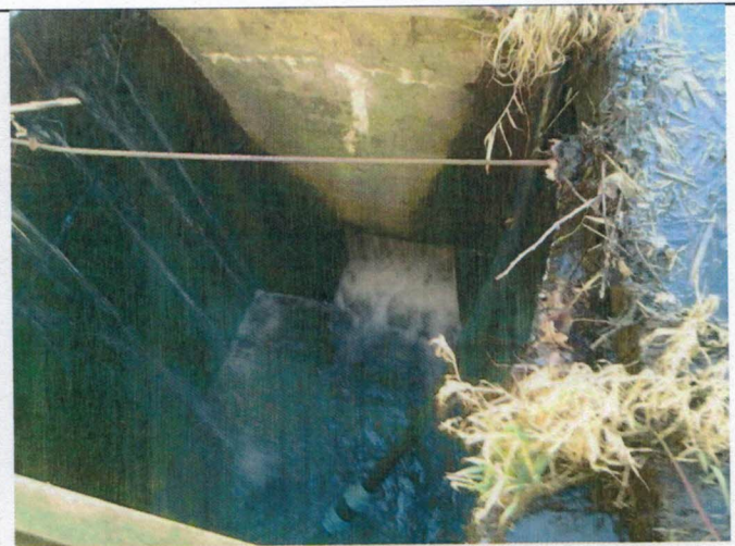
Foto G.2.2 Pohled na přelivné hrany a do spádiska sdruženého objektu.
