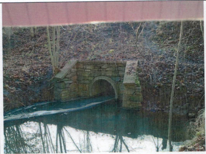
Foto G.2.7 Pohled na výtokové čelo sruženého objektu.
