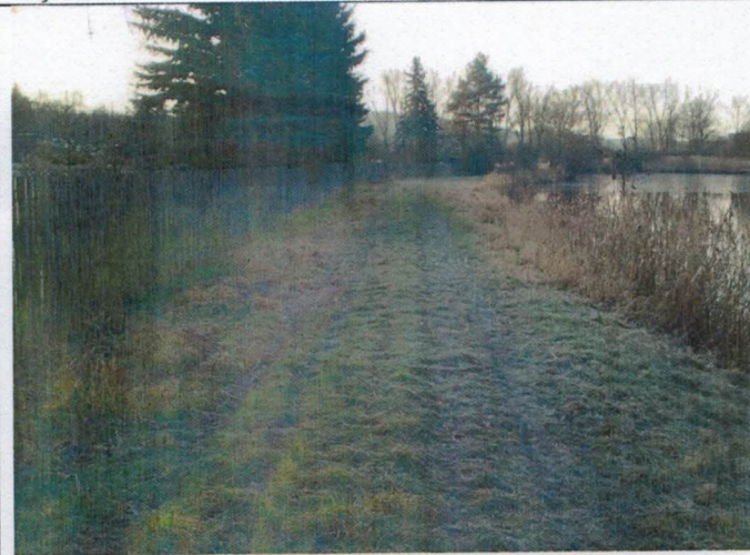
Foto G.2.4 Pohled na břeh východní hráze
