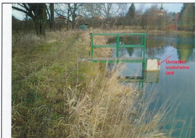
Foto G. 2.1 Požerák, šipka ukazuje na místo osazení vodočetné latě. Lať může být osazena také na druhé straně konstrukce.
