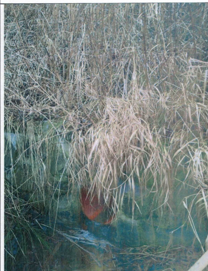
Foto G. 2.5 Pohled na výtokové čelo dnové výpustě od požeráku.
