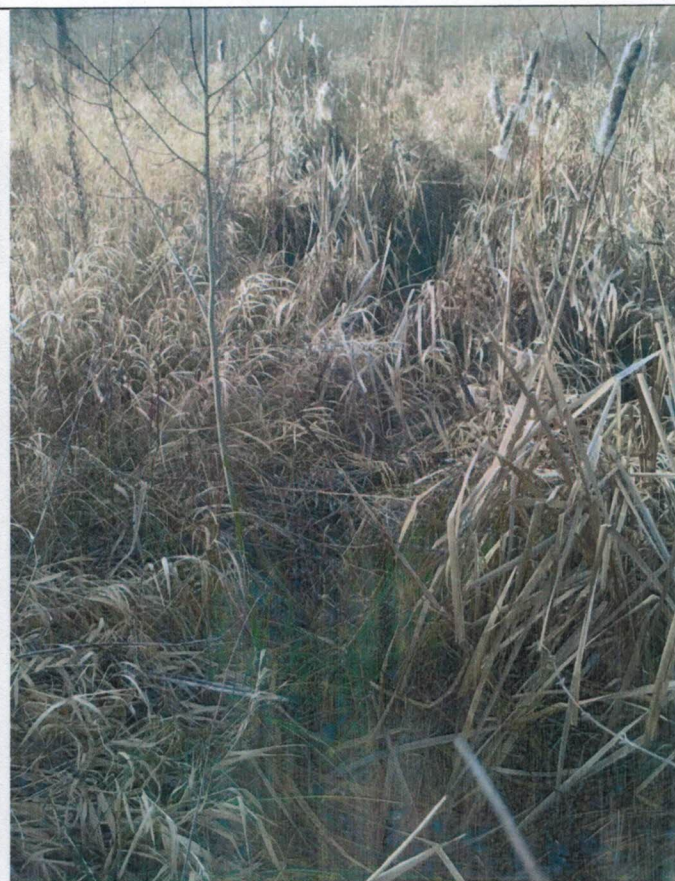
Foto G. 2.6 Pohled na odpadní koryto od dnové výpustě.
