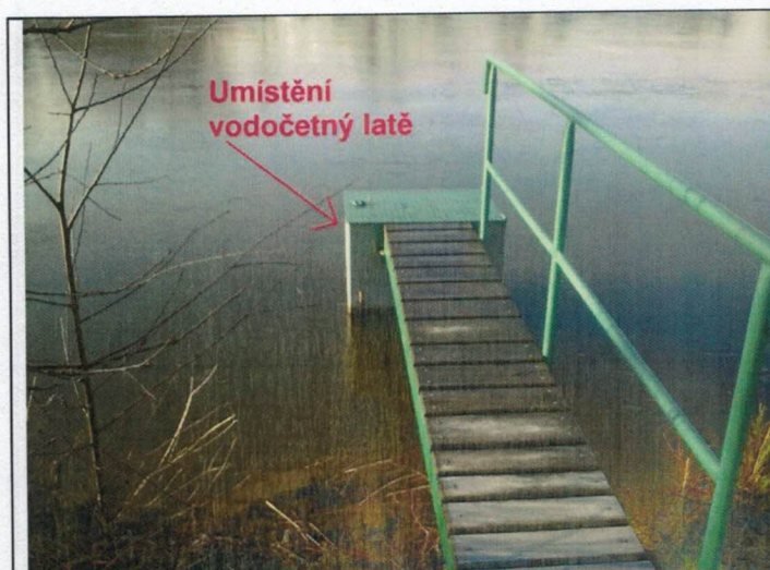
Foto G. 2.1 Požerák, šipka ukazuje na místo osazení vodočetné latě. Lat' může být osazena také na druhé straně konstrukce.
