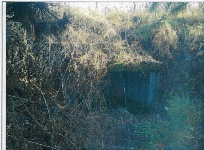
Foto G. 2.5 Pohled na výtokové čelo propustku (bezpečnostního přelivu).
